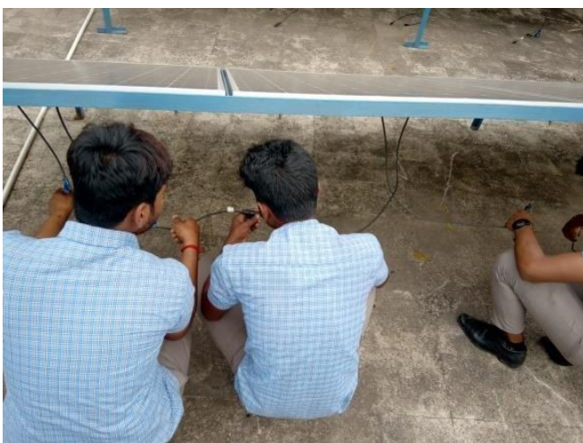
Câblage des modules photovoltaïques
