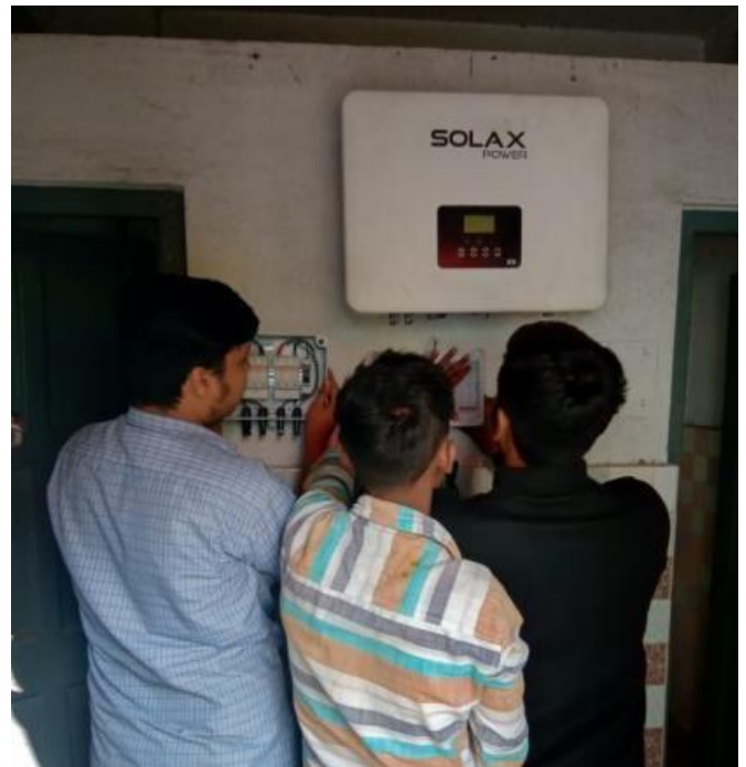
Montage de l'onduleur photovoltaïque et du système de monitoring
