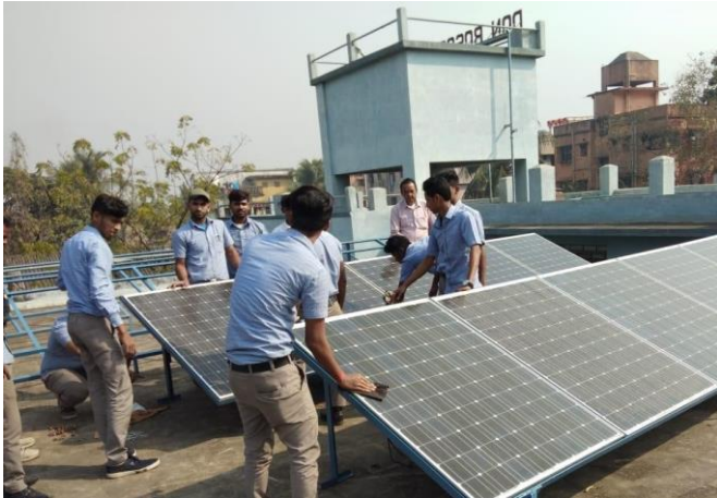
Montage des panneaux solaires
