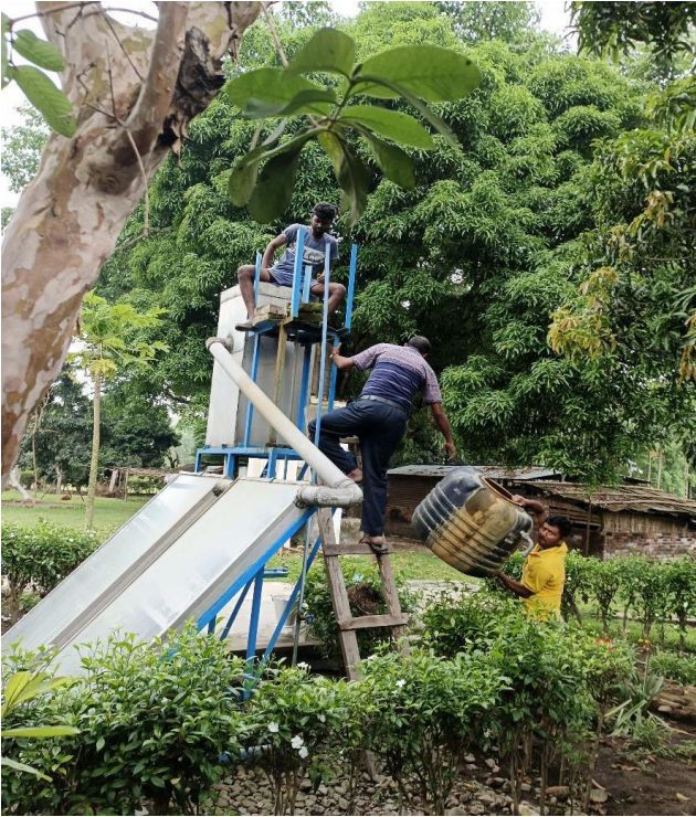
Figure 6 : Remplacement du réservoir d'eau chaude à Mariabasti.
